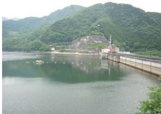
写真 1 草木ダム。独立行政法人水資源機構草木ダム管理所のご協力により、右手に見えるダム堰堤より採水した。
